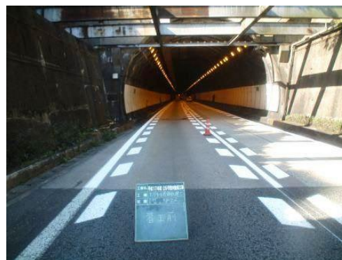
写真－2 坑口付近
