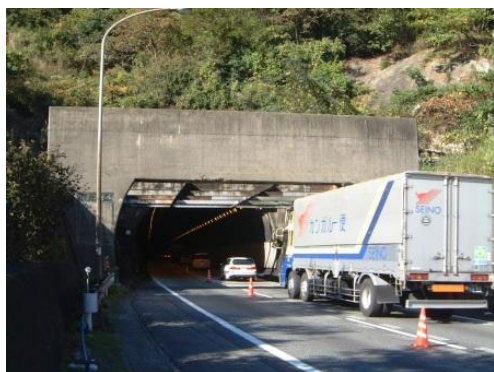
写真－1 坑口手前の状況
