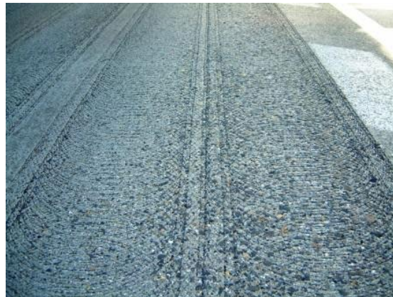
写真－5 処理後のコンクリート舗装面
