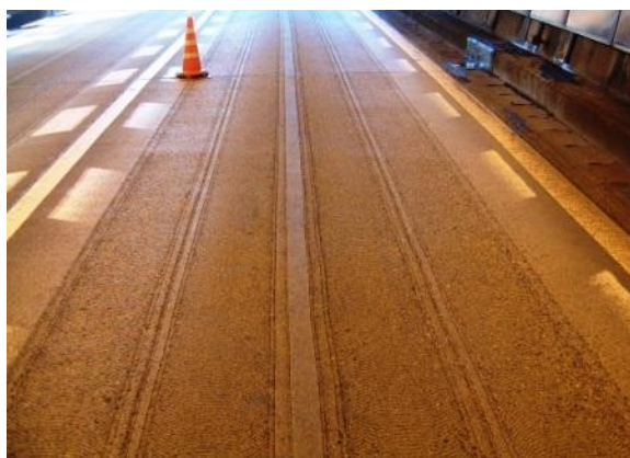
写真－4 処理後のコンクリート舗装面
