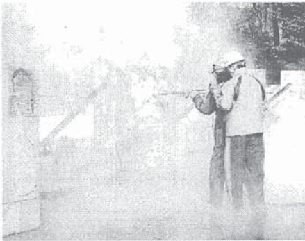
写真2 ウォータージェット照射状況 (1穴回転ノズル, 50MPa, 19.2ℓ/分)
