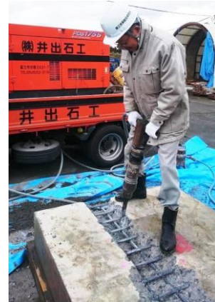
写真-2 試験体のはつり状況
