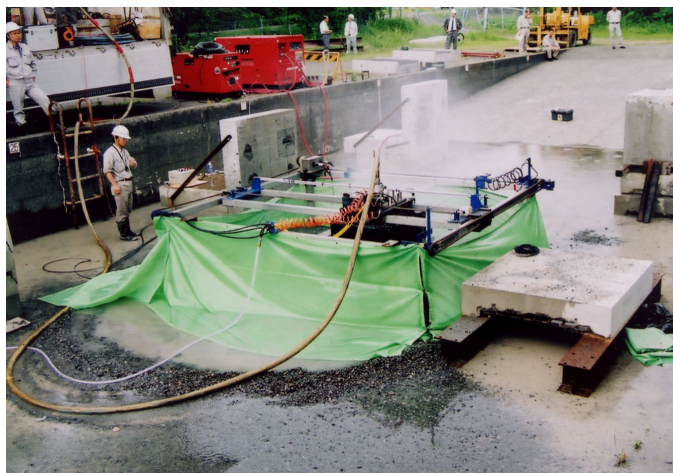
写真5 フレーム式はつりシステム（旋回式ノズル）#
