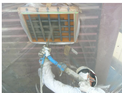
写真6 鉄筋背面への充填性試験
