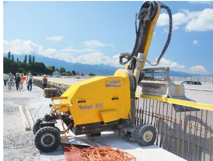
WJロボットによるはつり処理
