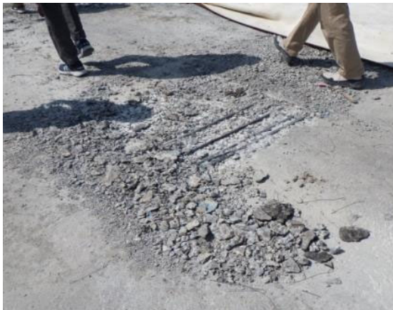
床版上面の土砂化
