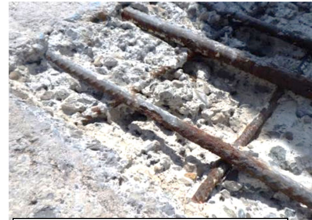
マクロセル腐食
