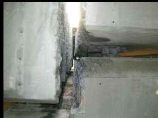
主版側面の状況
