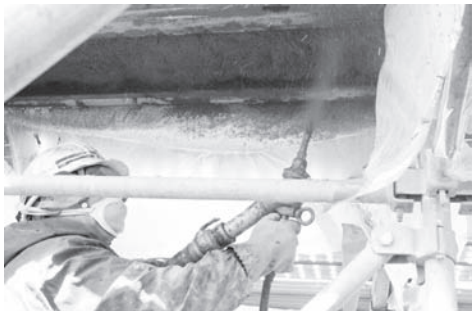
写真—5 吹付けによる断面修復の状況
