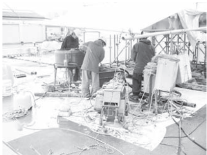
写真—6 吹付け用のモルタルポンプとミキサ
