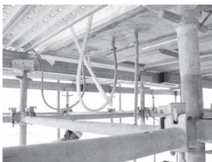
写真-7 真空吸引法による深部への注入状況 注入用パイプ（φ12mm）と排出用パイプ（φ9mm）の設置状況
