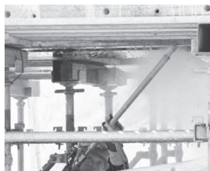
写真—3 ウォータージェットによる脆弱部のはつり状況
