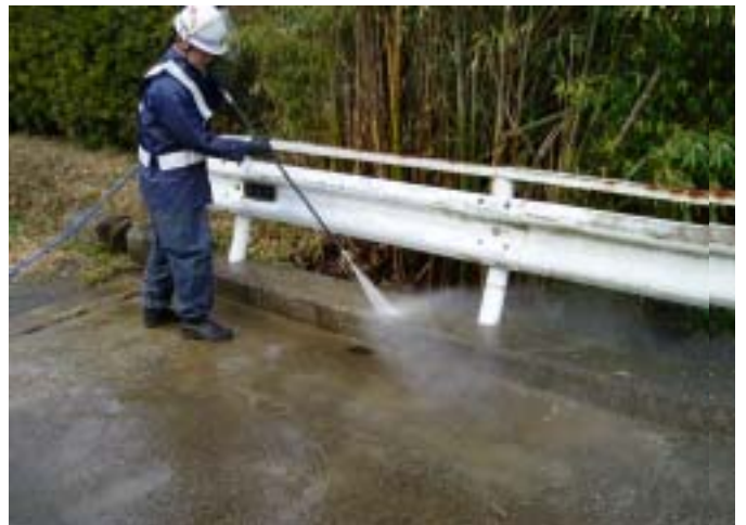
写真2 ハンドガンWJによる土砂の洗浄
