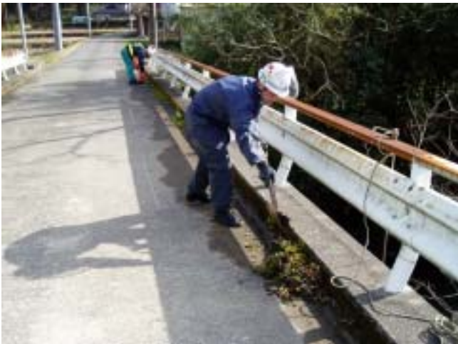
写真1 橋梁側部の土砂の除去（スコップによる）
