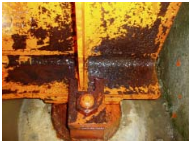
写真5 WJで下地処理された支点付近のけた
