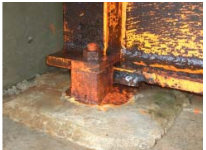
写真4 ハンドガンWJで洗浄された支承部
