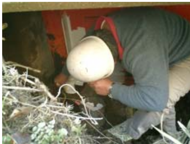
写真6 地元橋守による部分塗装
