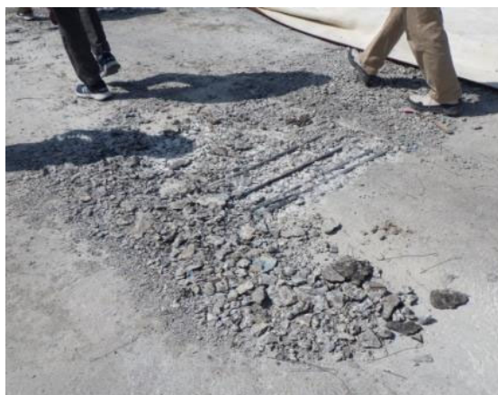
床版上面の土砂化
